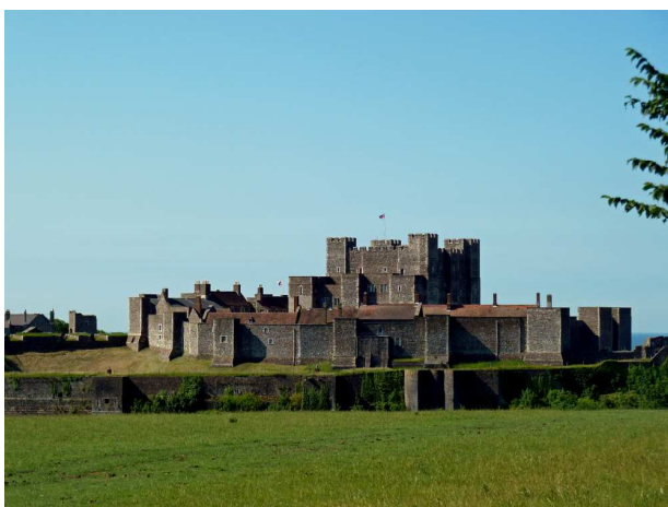
Burg von Dover, Rückseite
