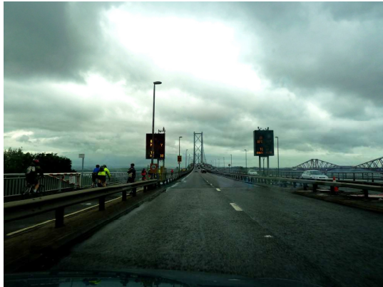
Brücke über den Firth of Forth
